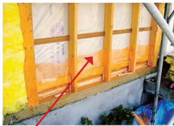
防湿ポリフィルムを隙間なく気密に張る
