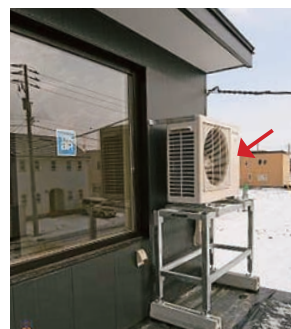
エコキュート室外機
